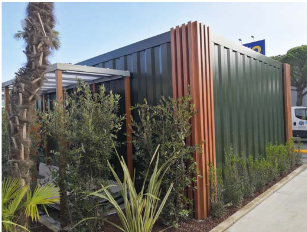
Cat. 3 : Struttura prefabbricata uso magazzino / Prefabricated structure for storage Caratteristiche: interni in cartongesso, struttura su ruote / walls and ceiling in drywall, structure on wheels Cliente: McDonald's
