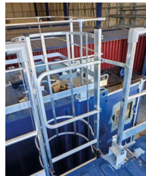
Cat. 1 : Containers modificati per installazione impianti di biometano / Modified containers for the installation of biomethane plants. Caratteristiche: parapetto su tetto per ispezione camini/ railing on roof for chimney inspection Cliente: Hysytech S.r.l.
