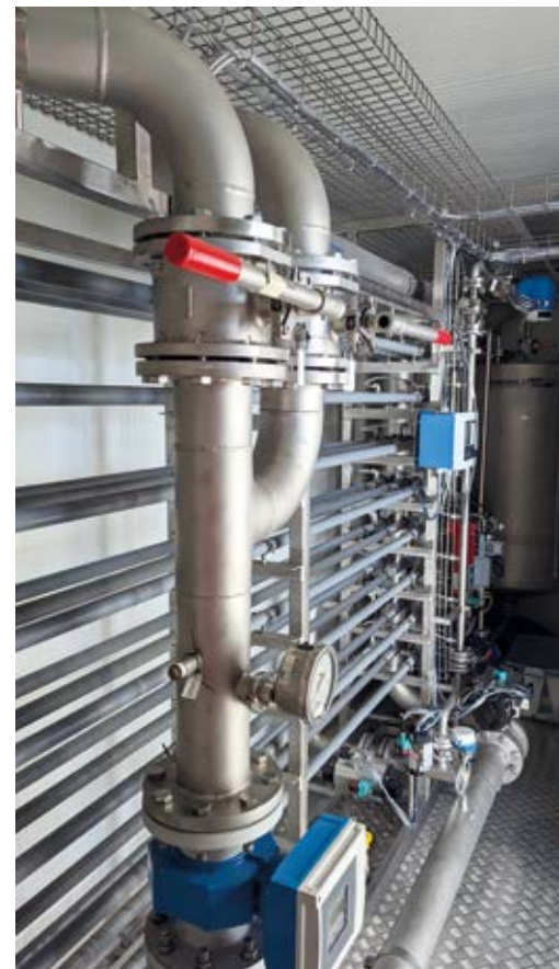
Cat. 1 : Container Prototipo per sistema di super filtrazione dell'acqua / Prototype Container for water super filtration system Caratteristiche: impianto pilota mobile, completo di allarmi O 2 , incendio e assenza corrente / pilot plant complete with O 2 , fire and power alarms Cliente: Hydro Air Research Italia S.r.l.
